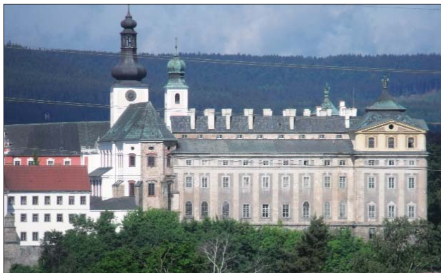
V letech 2014–2015 se uskutečnila rozsáhlá revitalizace broumovského kláštera za cca 250 mil. Kč, opravy se týkaly zhruba jedné pětiny objektu kláštera a také klášterní zahrady včetně budov, které se v ní nacházejí.
